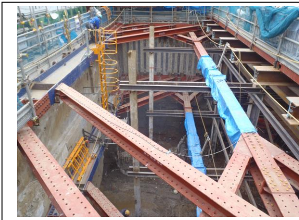
<建築物件> 戸田建設(株) 都内某現場
